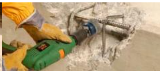
Rys. 2. Czyszczenie zbrojenia.
