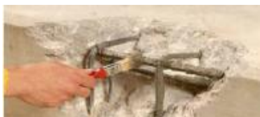
Rys. 3. Zabezp. antykoroz.
